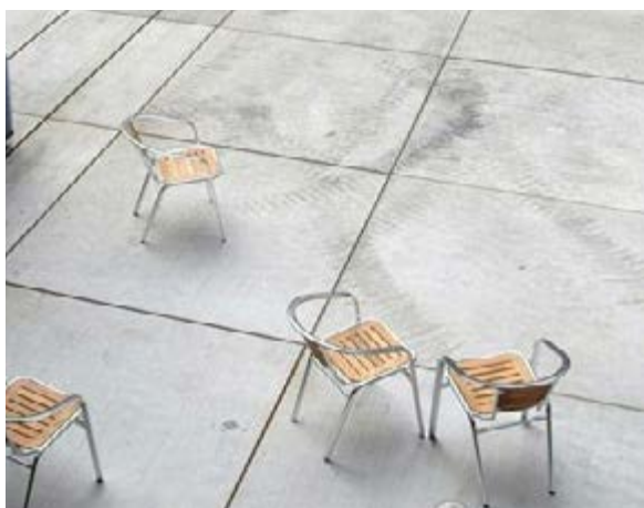
Beton-belægning på torvet
