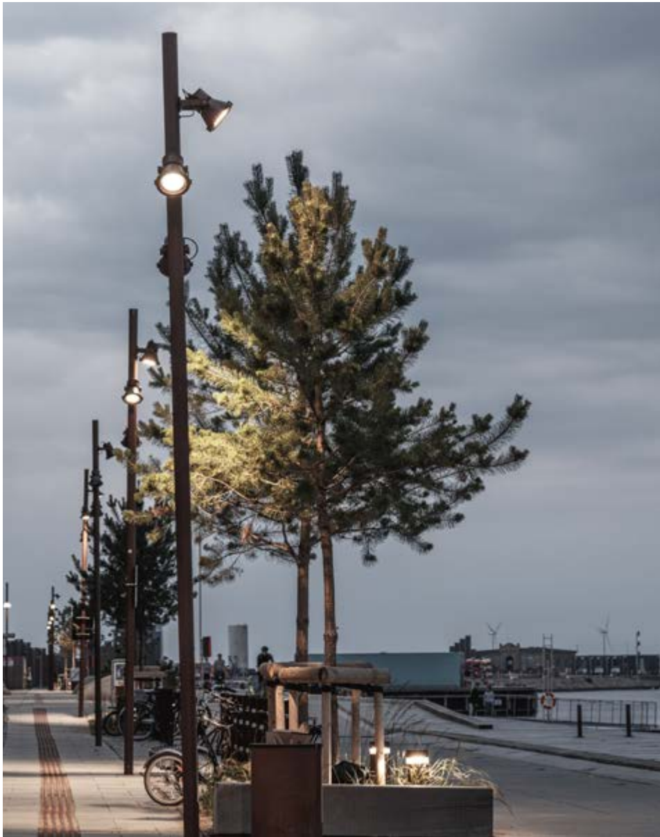
Eksempel på lysmaster med projektørlys langs Blåvandvej
