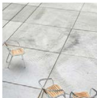
Vejareal: In situ støbt beton 2400 x 800-2750
